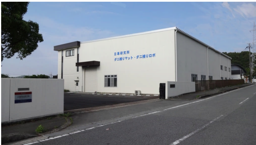
相生工場（兵庫県・相生市）
